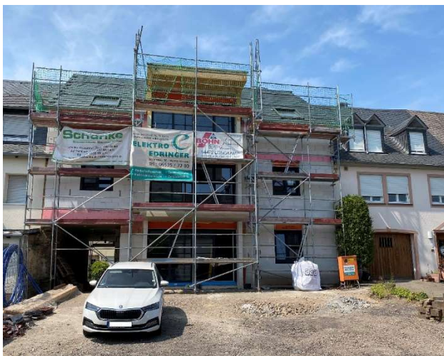
Abbildung 44: Sanierung eines zuvor abgerissenen Hauses in der Trarbacher Straße (mit Fahrstuhl für seniorengerechtes Wohnen) (Quelle: Horst Gorges)
