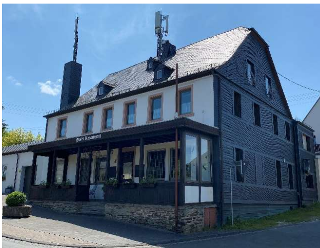
Abbildung 32: Leerstehendes Gasthaus (Quelle: Horst Gorges)
